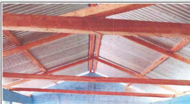
Foto1: Desmontaje y sustitución de estructura de madera por estructura de metal
