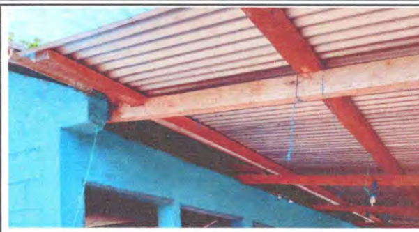
Foto 2: Montaje, instalación y suministro de cubierta de laminas troqueladas.
